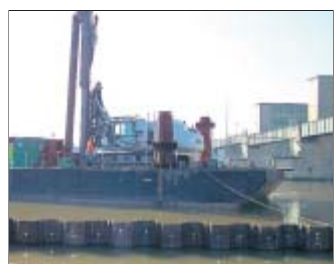
Die Tiefbauarbeiten für ein neues Wasserkraftwerk gestalten sich schwierig. Foto: pr
